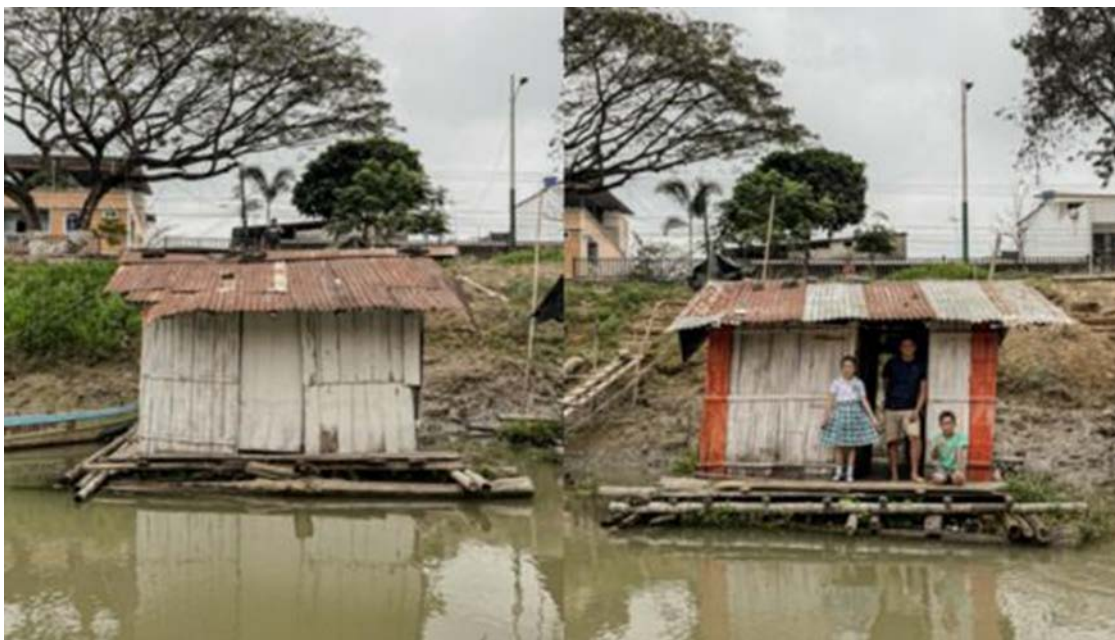
Figura 3. Situación actual de viviendas flotantes en el río Babahoyo.
