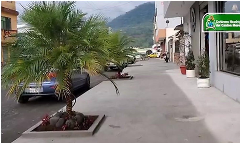
Figura 11. Diseño de vía casi terminado (Tarqui y Amazonas).
